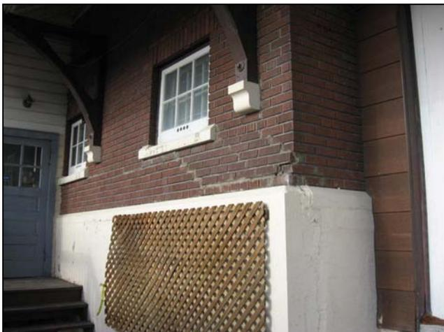
**Photo 41. Infiltration d'eau sous les appuis et les corbeaux**
