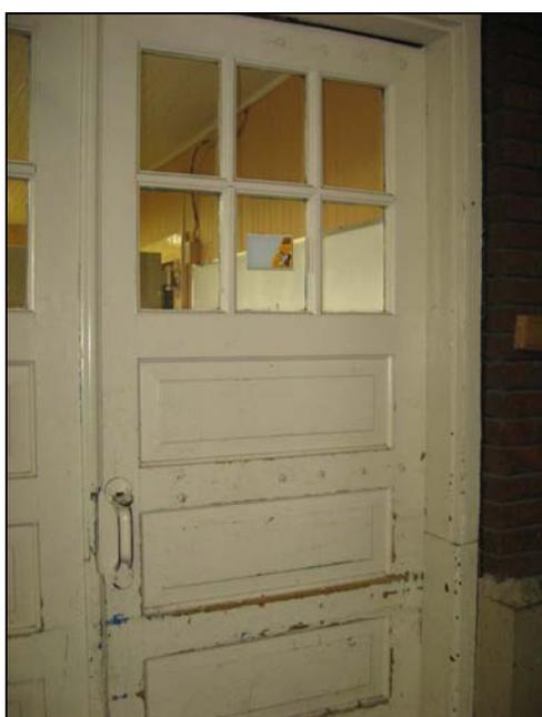
**Photo 55. Porte d'origine vue de l'intérieur, avec panneaux encaissés et fenêtres à carreaux**
