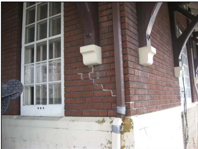
**Photo 40. Infiltration d'eau sous les corbeaux soutenant la console**
