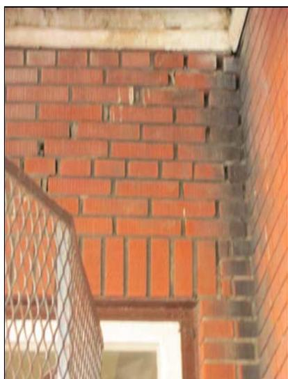
**Photo 42. Problème de rejointoiement à l'angle des murs de brique**
