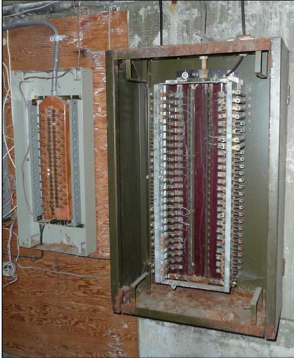
**Photo 34. Sous-sol, tableau des branchements pour la salle de téléphonie – est-ce d'époque ?**
